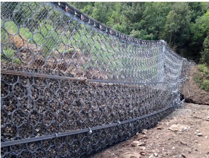
Durch Geschiebetransport gefülltes Murgangschutznetz.
