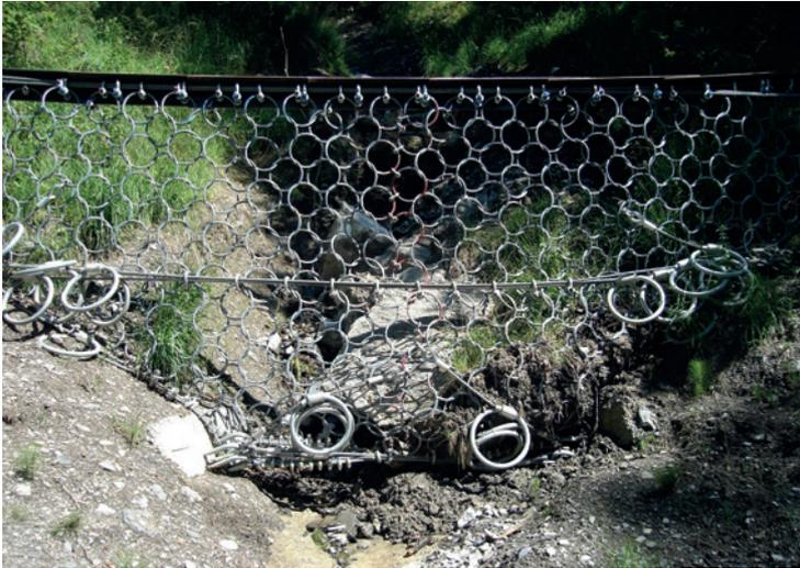
Verklauserung des Basisdurchlasses aufgrund der Teilfüllung eines Murgangschutznetzes.
