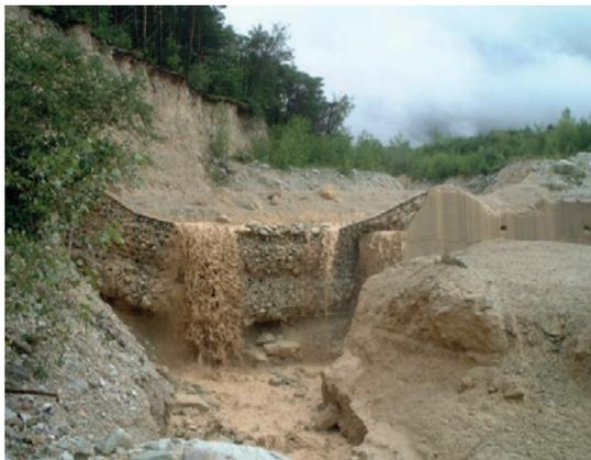
Sanierungsabschnitt 1 mit VX-Barriere gefüllt (Bild: [G]).
