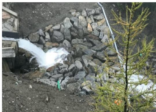
Sperre mit grossen Blöcken vorverfüllt, Blick von oben (Bild: [I]).
