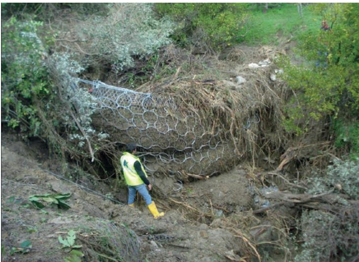
Gefülltes und überströmtes Murgangschutznetz.
